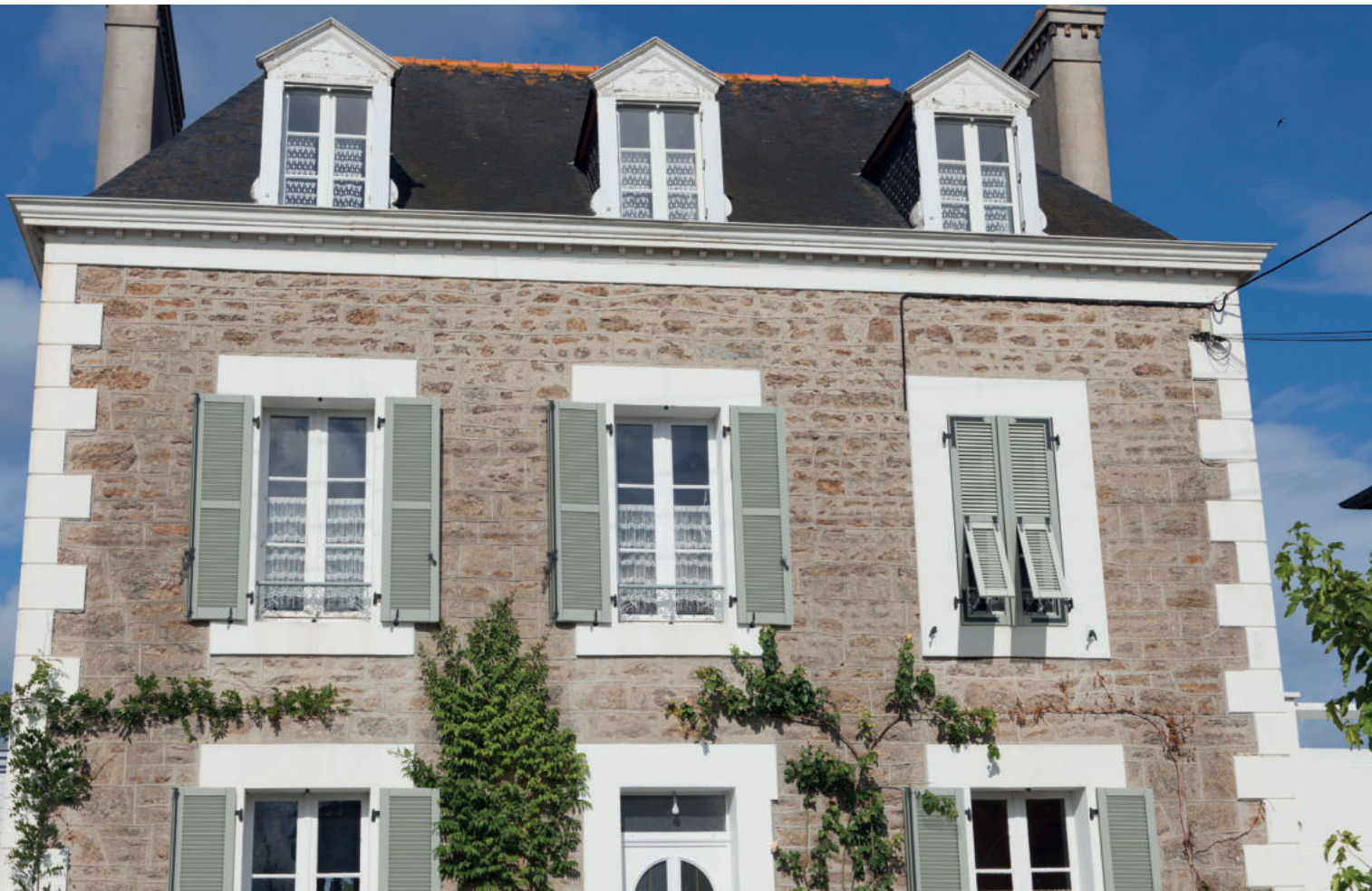
Volets battants à cadre en bois, lames persiennes ajourées à l'américaine, projection à la niçoise, finition peinture. Coloris : gris clair RAL 7035 en option. Quincailleries coloris noir en standard.
