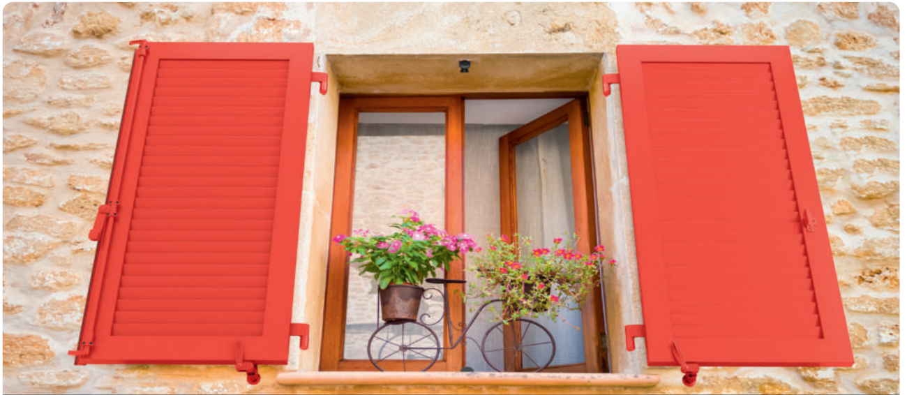
Volets battants à cadre en alu extrudé, lames persiennes ajourées à l'américaine avec espagnolette Cubique. Coloris : rouge feu RAL 3000 et quincailleries assorties en option.
